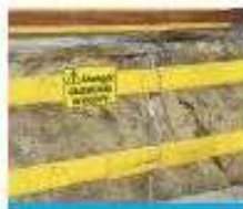
Zabezpieczenie krawędzi wykopu.
