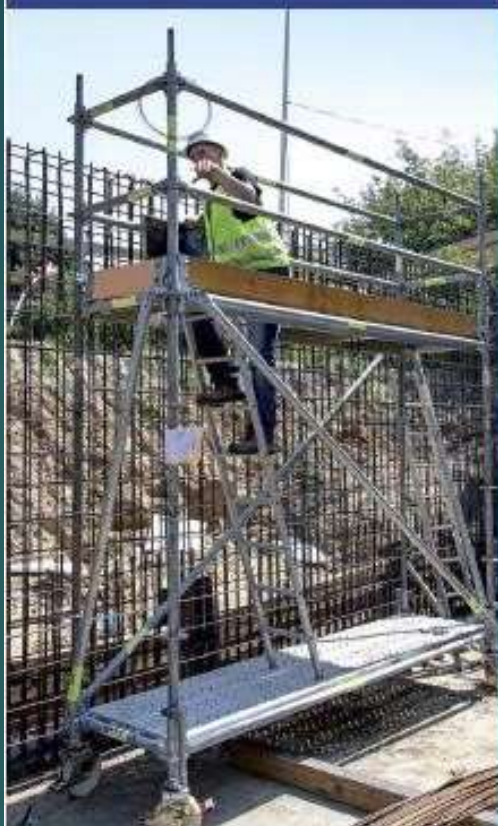
Hamulec rusztowania przejezdnego.
