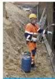
Pracownik może pracować wyłącznie w wykopie zabezpieczonym przed osunięciem gruntu.
