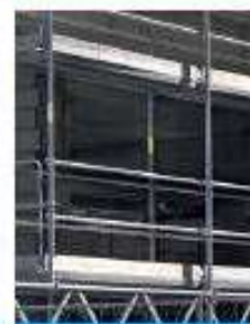
Balustrady ochronne od szczytu rusztowania.
