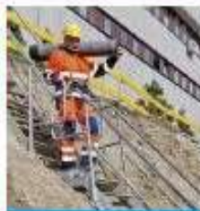
Bezpieczne zejście do wykopu.
