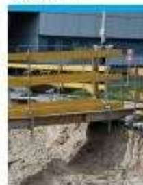
Przebiegi nad wykopem musi być zabezpieczone balustradami.
